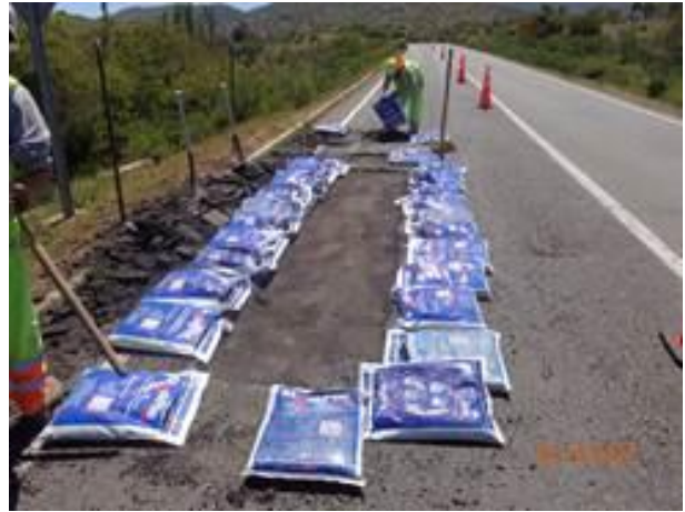
Reparación de baches y grietas
