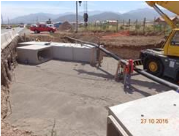
Instalación cajones prefabricados en tramo 1.4
