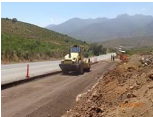
Labores de perfilado y compactado en desvío El Totoral.
