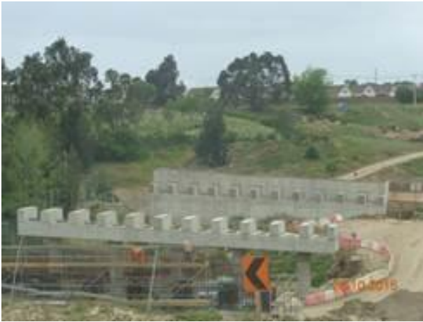
Trabajos de Enfierradura Estribo Puesto La Laguna
