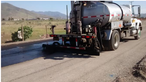
Trabajos Pavimentacion Desvio El Peñón..
