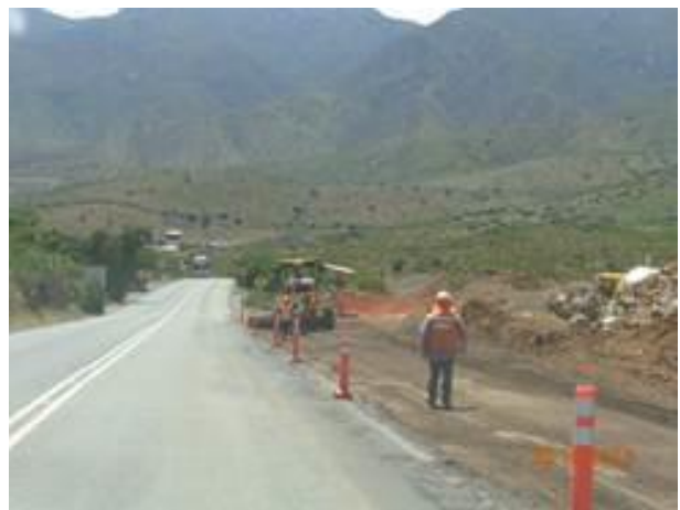
Labores de perfilado y compactado en desvío El Totoral.
