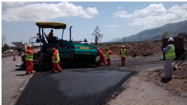
Trabajos Pavimentación Desvio El Peñon.
