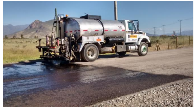
Trabajos Pavimentacion Desvio El Peñón.
