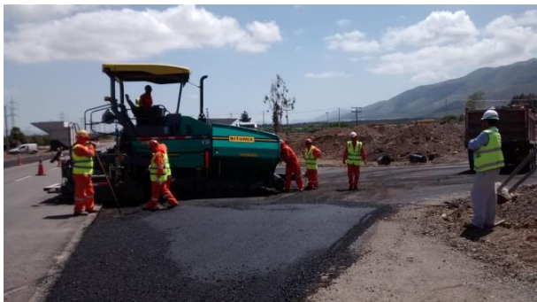
Trabajos Pavimentacion Desvio El Peñón.
