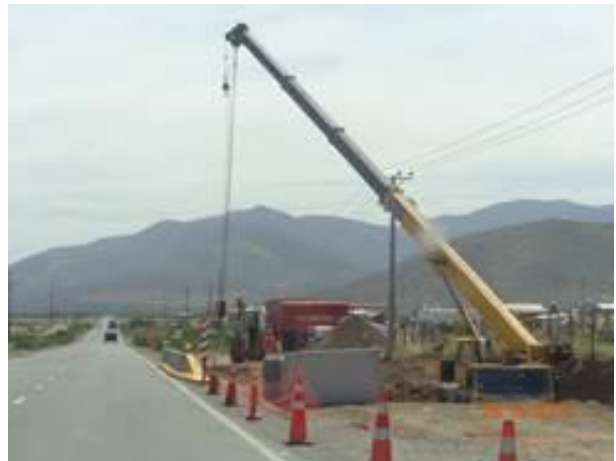
Instalación cajones prefabricados en tramo 1.4
