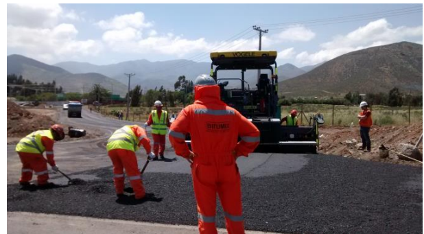
Trabajos Pavimentacion Desvio El Peñón.
